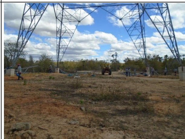
Figura 12.6.1-8 – Atividade de montagem de estrutura (outra obra).
