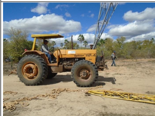
Figura 12.6.1-7 – Atividade de montagem de estrutura (outra obra).
