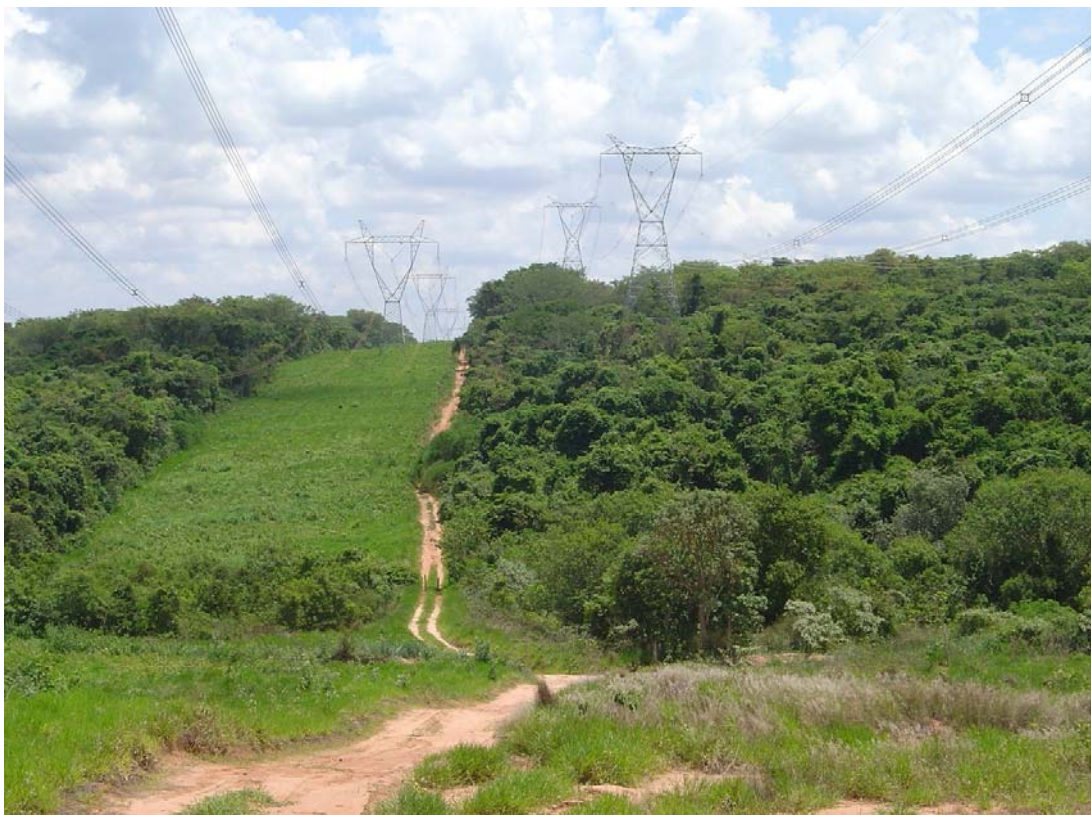
Figura 3.4-1 – As torres da LT mais recente (à direita), foram alteadas, preservando a vegetação nativa existente.
