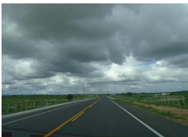
Foto 6.3.2-7 – Estradas pavimentadas e em bom estado na maior parte dos municípios da AII.
