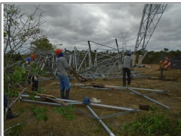
Figura 12.6.1-5 – Atividade de montagem de estrutura (outra obra).
