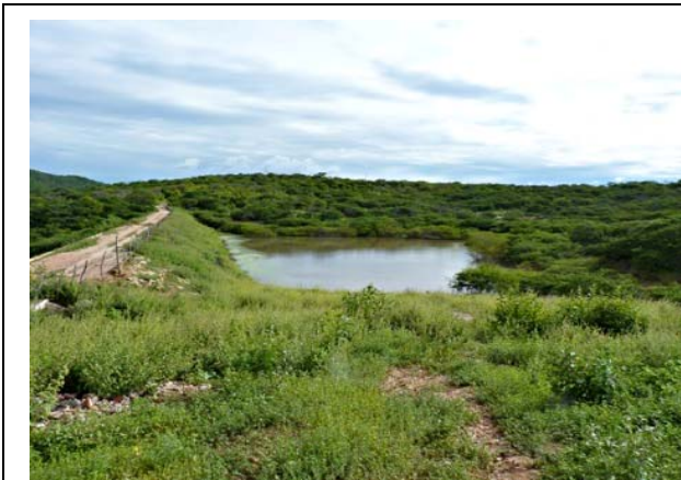
Foto 6.3.3-1 – Açude na CRQ Serra do Talhado. Município de Santa Luzia Coord.: 24 M 726.767 E / 9.223.433 S.
