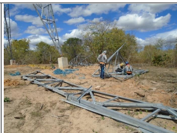
Figura 12.6.1-6 – Atividade de montagem de estrutura (outra obra).
