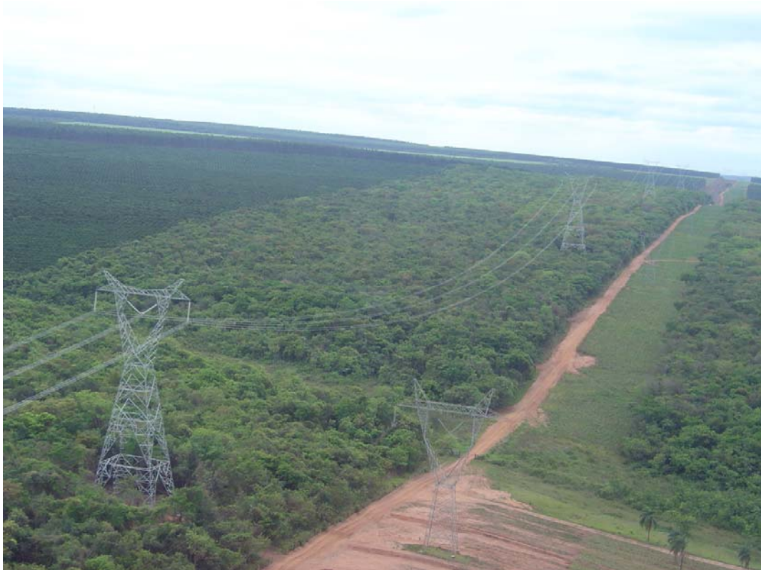
Figura 3.4-2 – Nota-se que as torres da LT mais recente (à esquerda), foram alteadas, preservando a vegetação nativa existente.
