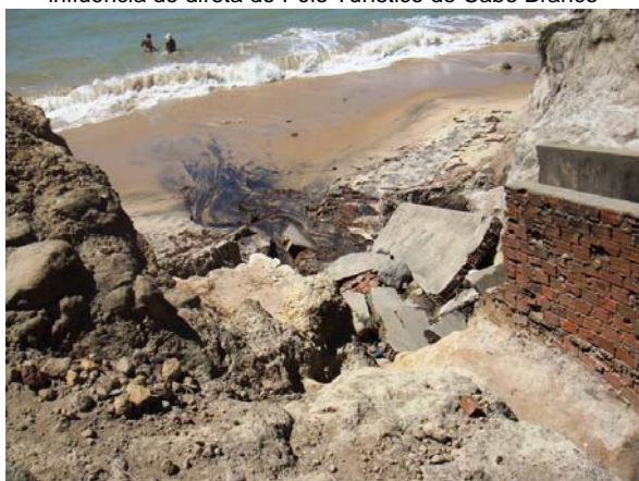
Figura A.2.3 – Vista do Exutório do sistema de drenagem da Estação Ciência, mostrando sério problemas erosivos
