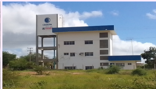
Central de Distribuição de água, em Picuí. Fonte: CRN-Bio, 2022.
