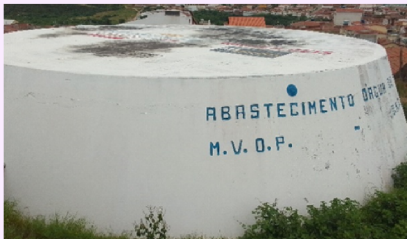
Fonte de abastecimento de água na zona urbana em Picuí. Fonte: CRN-Bio, 2022.
