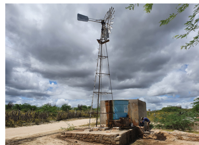
Bomba eólica utilizada na AID
