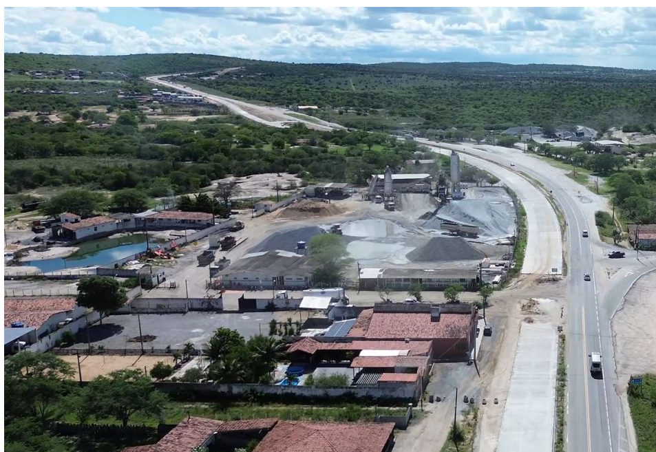
Visão geral do Canteiro de Obras, em operação.
