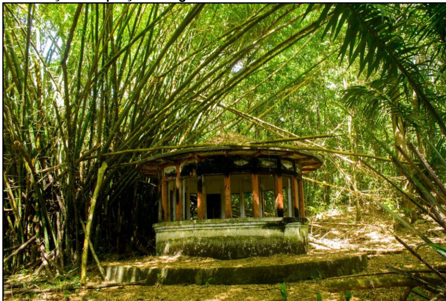
Figura 3.9. Poço de captação de água desativado no REVIS da Mata do Buraquinho
