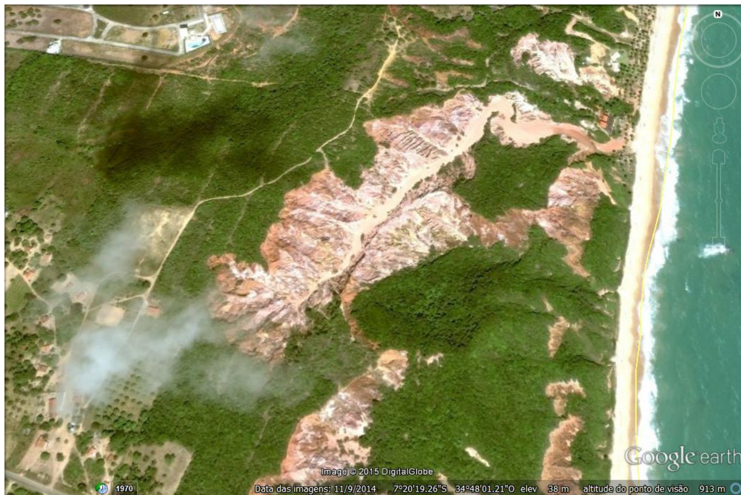
Figura 4: Maior erosão localizada na APA Tambaba
