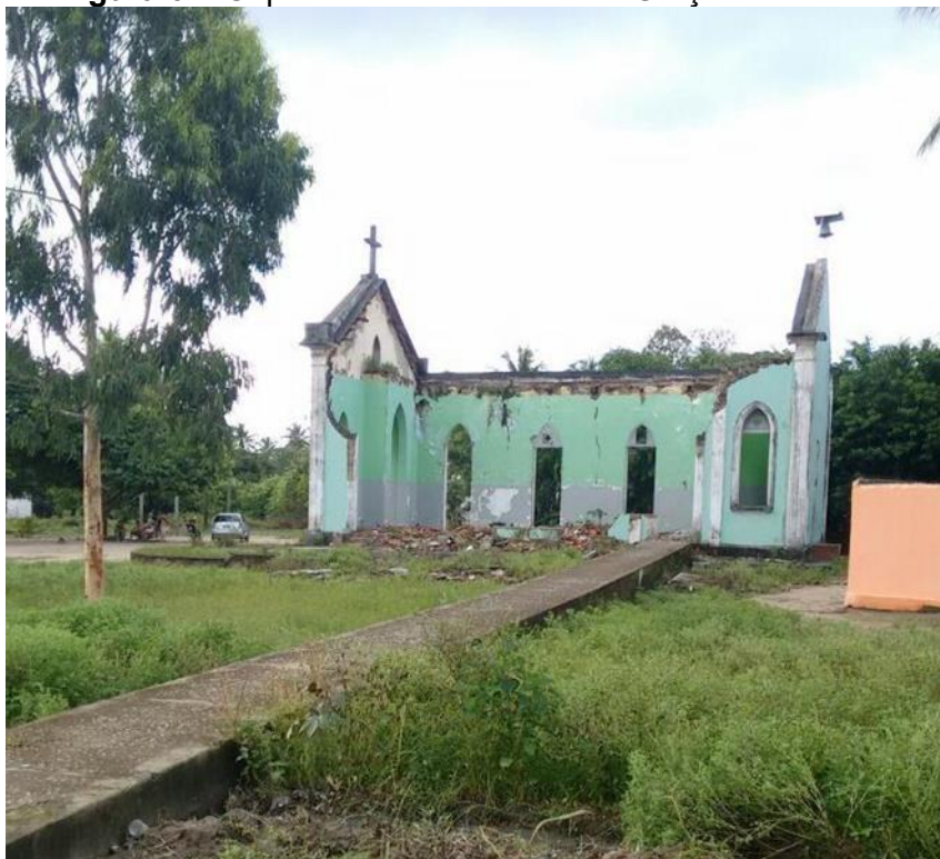
Figura 64- Capela Nossa Senhora das Graças em ruínas.
