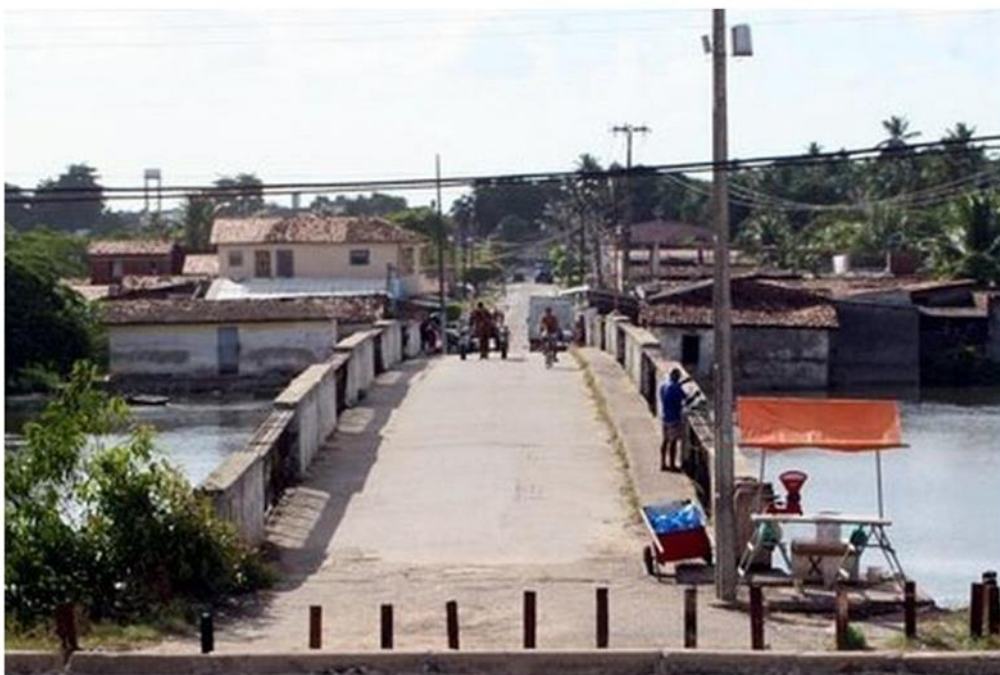
Figura 57- Ponte do Rio Sanhauá.
