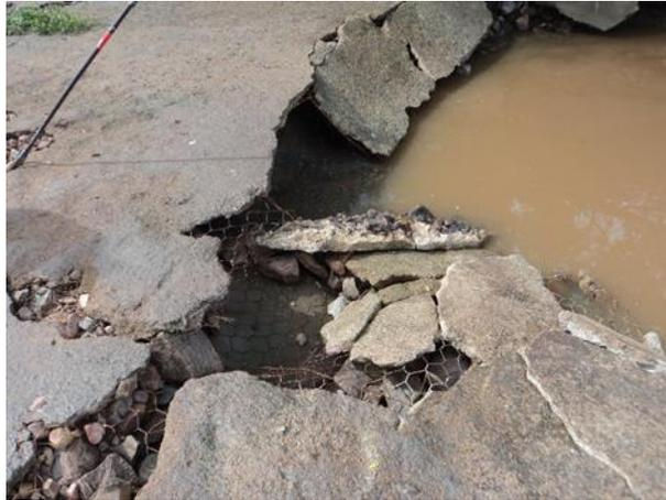
Figura 4.44 – Vista de margens erodidas na confluência de jusante entre canal de alívio e leito do rio do Peixe
