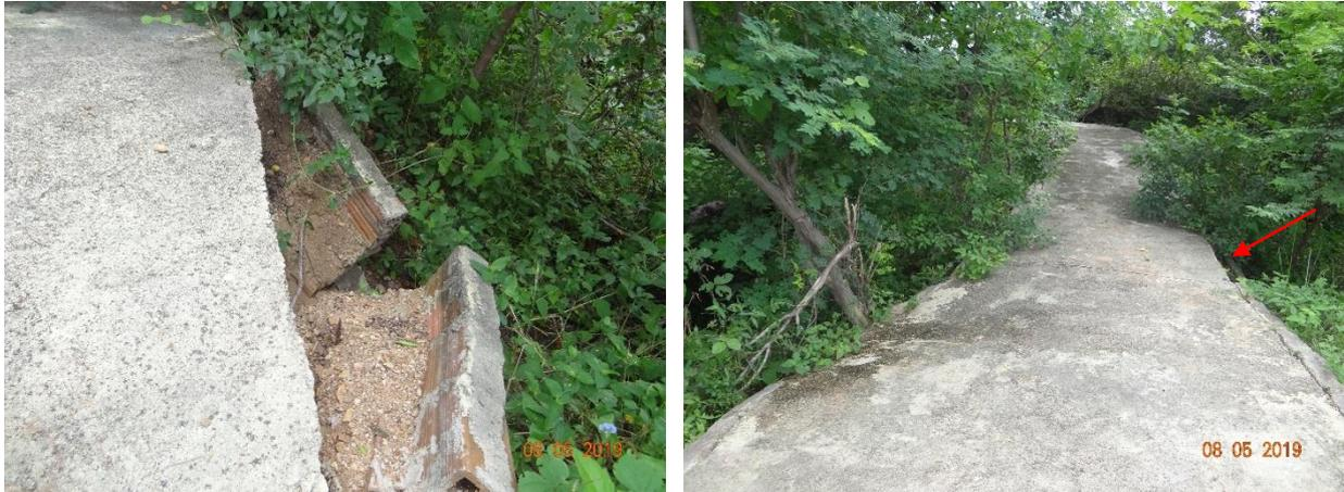
Figura 4.127 – Ausência parcial de contenção lateral em passarela sobre Passagem das Pedras
