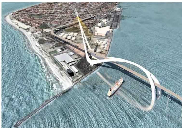
**Figura 7-** Perspectiva da vista lateral da ponte - arco não simétrico e arco triangular inclinado.
