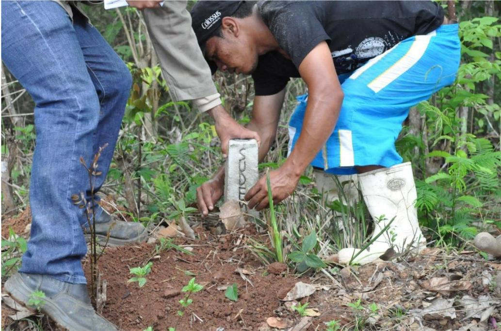
**Figura 12:** Materialização dos vértices da poligonal do PEMPF, a partir da implantação de marco de concreto com chapa metálica codificada. Foto: Thiago Silva.
