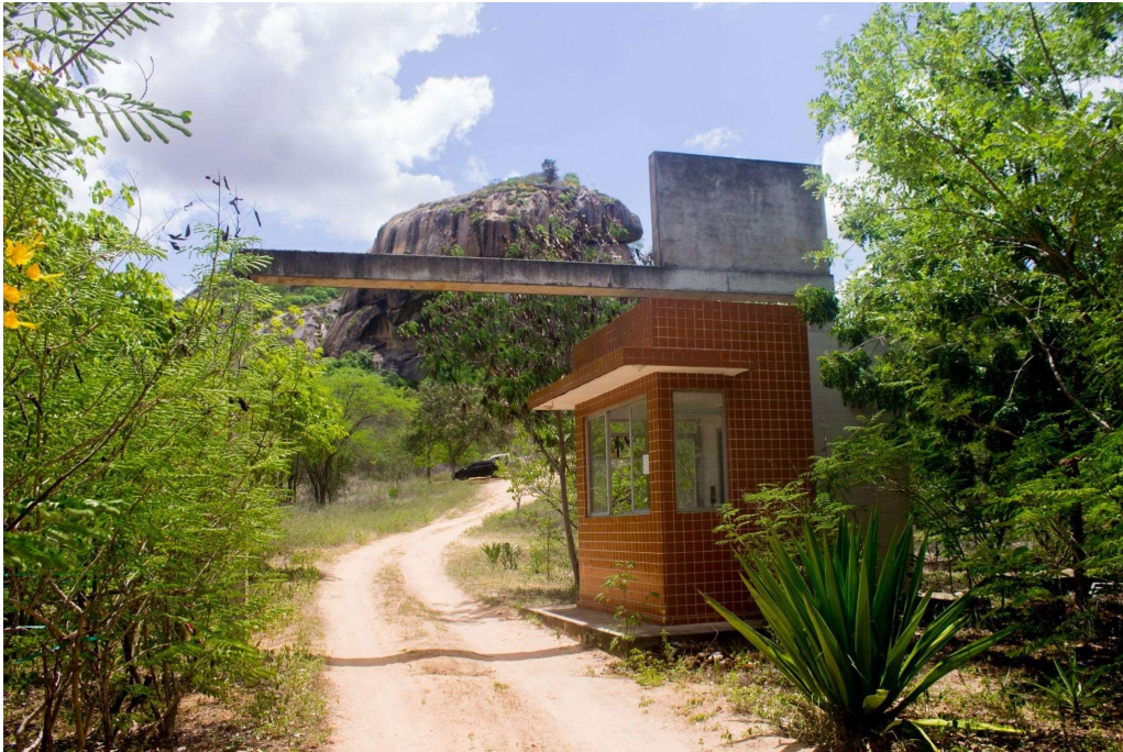
Figura 2.10. Guarita do Parque Estadual da Pedra da Boca, PB
